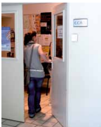
Le CCAS avant les travaux
